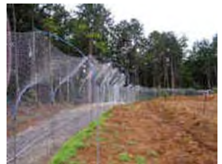
防護柵設置状況
