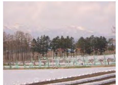
防風ネットの設置状況
